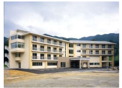
ケアハウス1番館竣工
